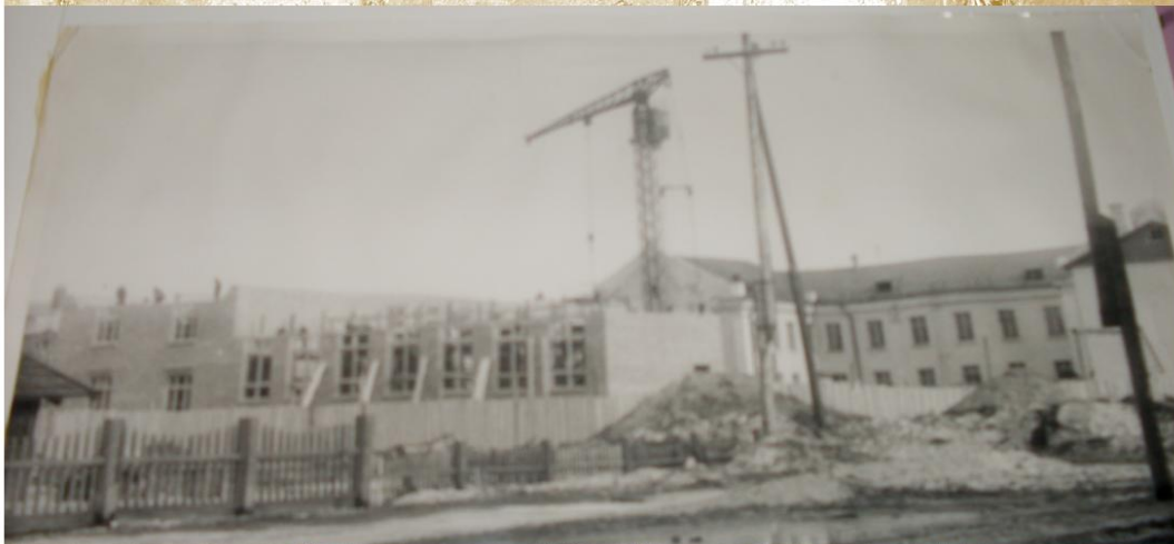
Строительство пристройки со спортзалом, 1959 г.
